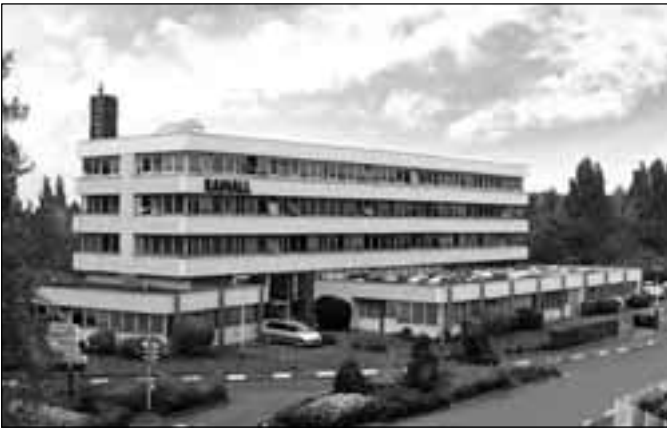
Head Office - Rosny sous Bois
